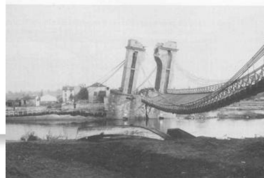
Le Pont d'Andrézieux. Crue de 1907.
